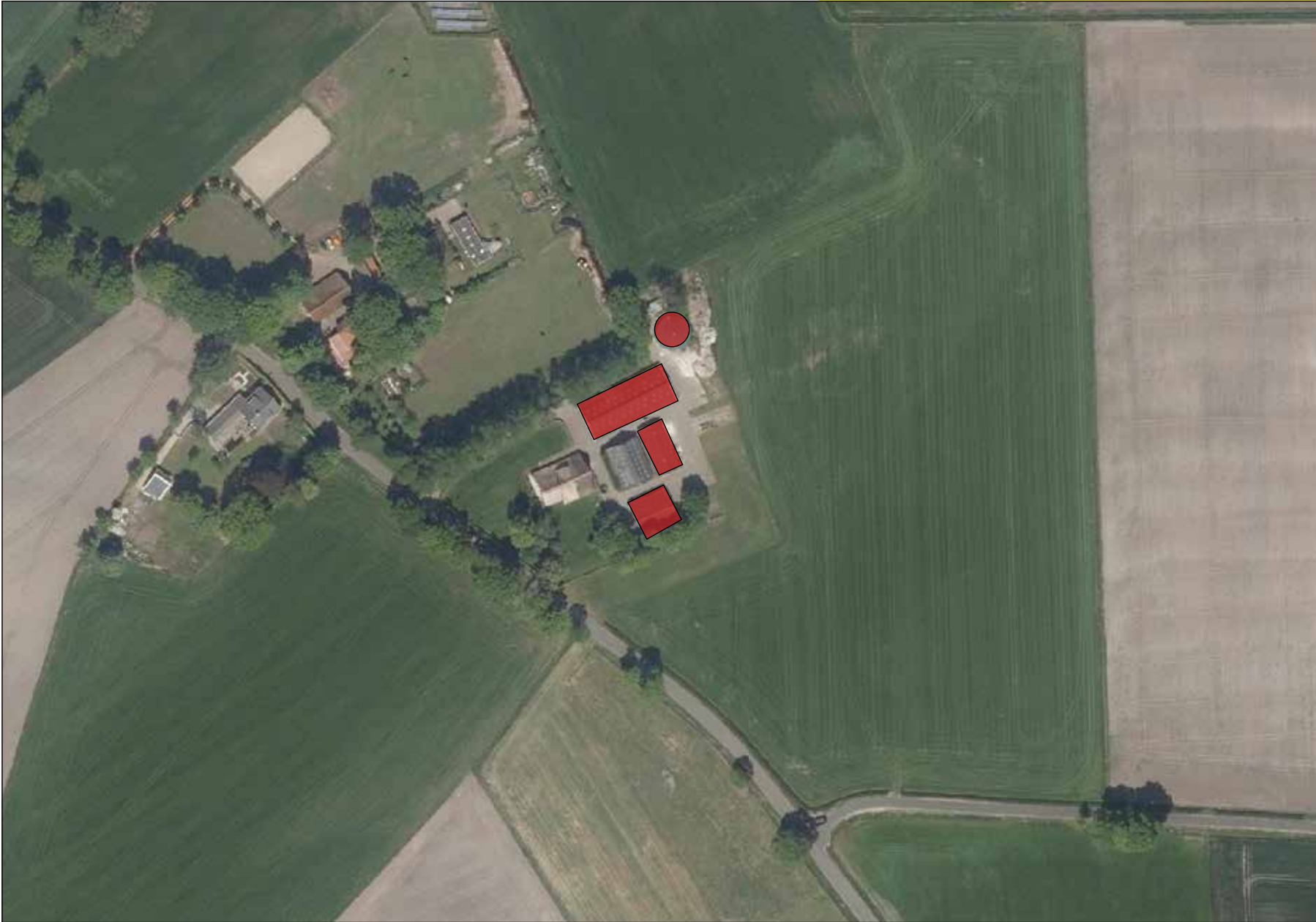
overzicht te slopen opstallen Hoogenweg 56 Venebrugge
